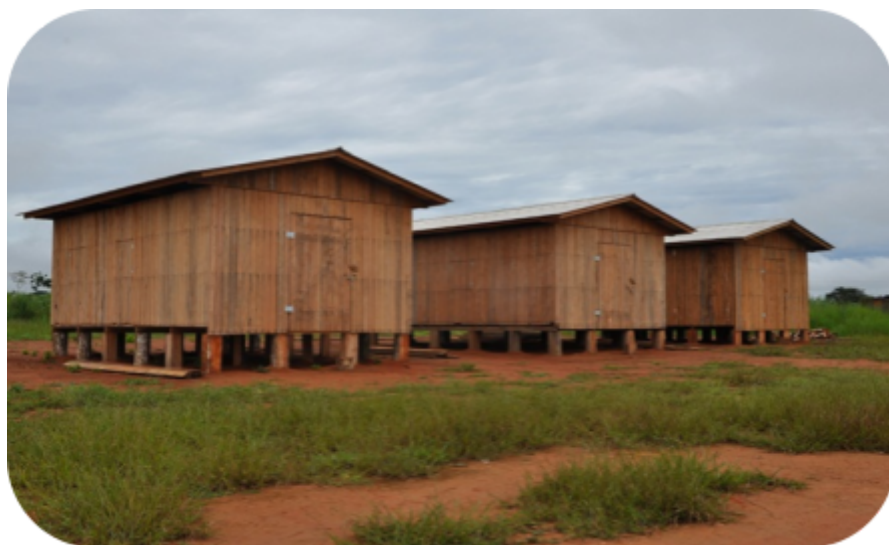
Imagem 6. Barracões de armazenamento de castanha do Brasil e de equipamentos construídos com recursos do projeto. Fonte: https://www.fundoamazonia.gov.br/
